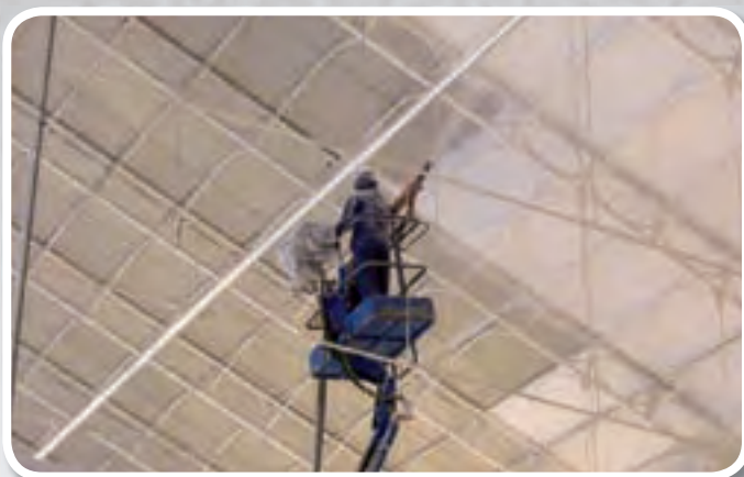
Sala congressi in fase di spruzzatura del rivestimento K-13
