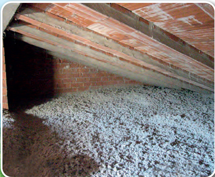
Isolamento di sottotetti non praticabili
