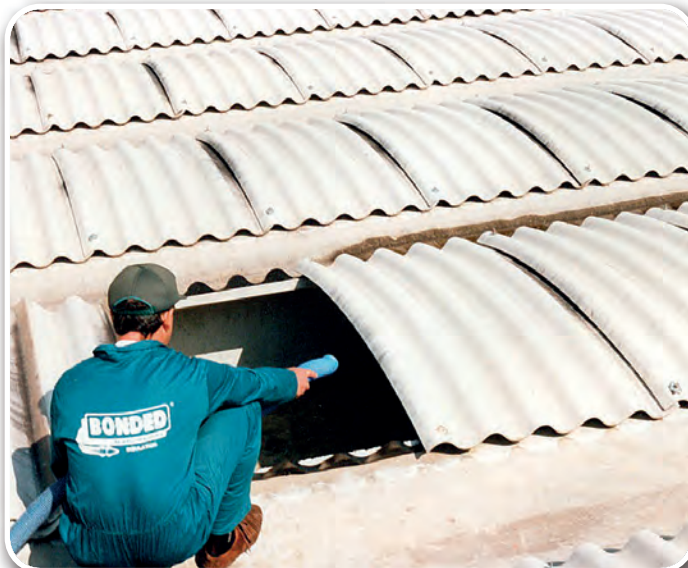
Isolamento dei capannoni industriali
