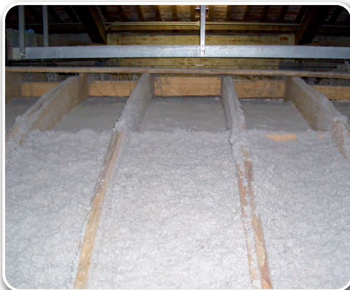
Isolamento dei volti delle chiese
